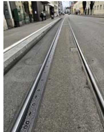
Für die Winterpause wurde der Gummi in den Tramschienen an der Haltestelle Bruderholzstrasse herausgenommen. Foto: GZ
