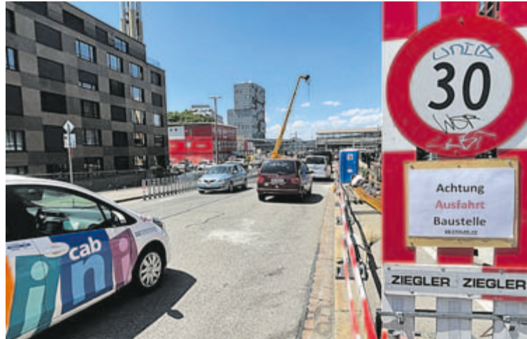
Da viele die Margarethenbrücke meiden oder meiden müssen, geht der meiste Individual- und SBB-Baustellenverkehr nun über die Peter Merian-Brücke via Hoch-, Solothurner- in die teilgesperrte Güterstrasse. Foto: Thomas P. Weber
