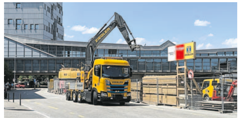
Viele schwere Lastwagen benötigt die SBB-Baustelle täglich, dabei hätte man sicher eine Lösung via Güterzüge ausarbeiten können, denn die SBB-Geleise stehen ja gleich nebenan. Foto: Thomas P. Weber
