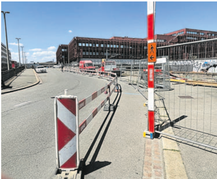
Wann die Bauarbeiten der Nautentor-Hochhäuser und der SBB-Stützmauern an der Hochstrasse beginnen, wissen wir nicht.
