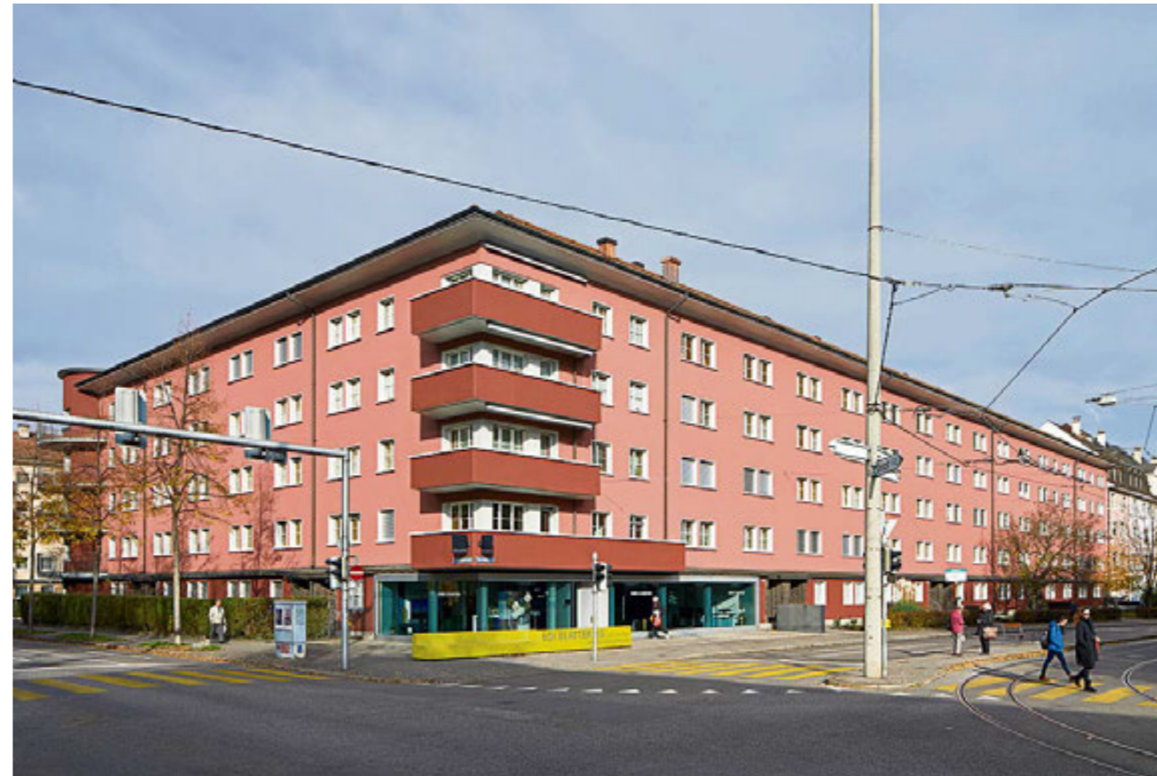
Die prägnante Ecke an der Gundeldingerstrasse-Thiersteinallee. Die Sockelpartien und Balkone sind optisch hervorgehoben. Sie bilden einen klaren farblichen Kontrast zu den übrigen Fassadenflächen. Foto: Tom Bisig, Basel
