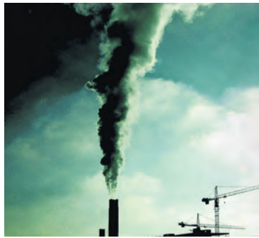
Und wie immer, wenn es so eisig kalt ist, dampft unser Wahrzeichen – das Fernheizwerk an der Solothurnerstrasse – über die Quartiersdächer. Foto: Martin Graf.
